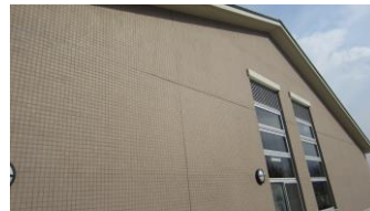
支援ハウス棟外壁タイル
