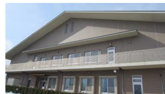
特養 3F 外壁タイル工事
