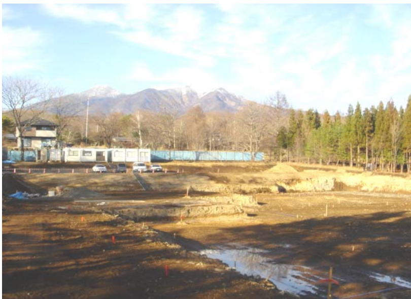
【第二仁生園建設 工事現場の様子】
