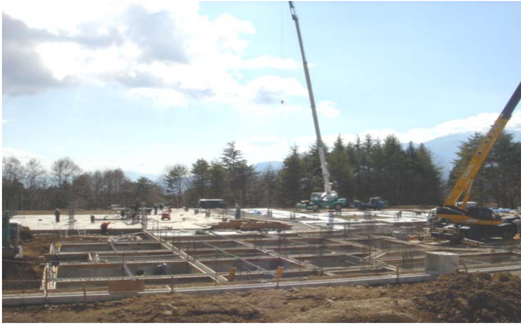
【第二仁生園建設工事の様子 現在、基礎工事が行われております】
